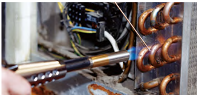
Hartlöten in der Kälte-Klima-Technik
