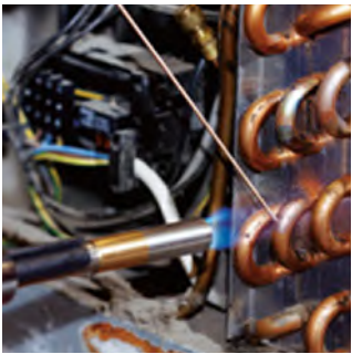
Hartlöten in der Kälte-Klima-Technik
