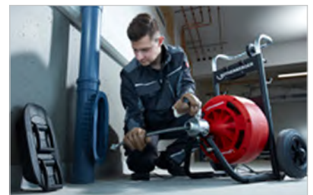
Reinigung eines Fallstranges mit 16 mm Spirale
