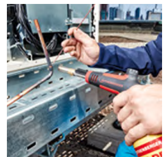
Hartlöten in der Kälte-Klima-Technik
