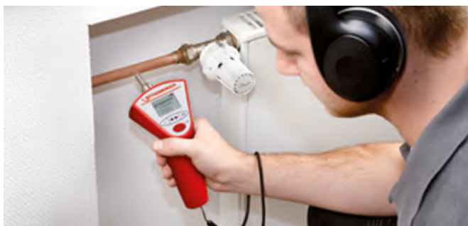
Akustische Leckageortung an Heizkörpern
