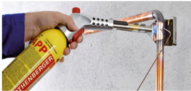
Hartlöten in der Gasinstallation
