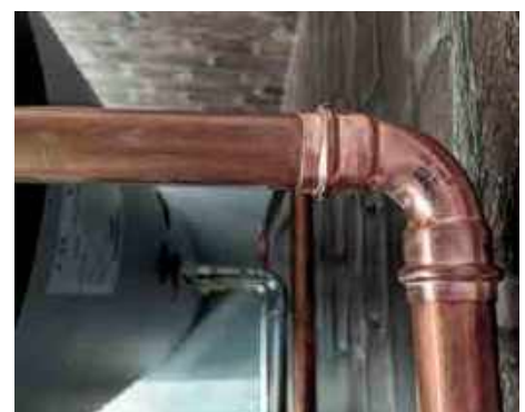
Рисунок 16 aesPREX UNIKO - Встановлення опалення
