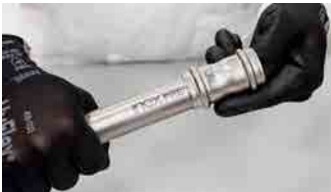
Рисунок 24 - Вставлення труби в прес-фітинг
