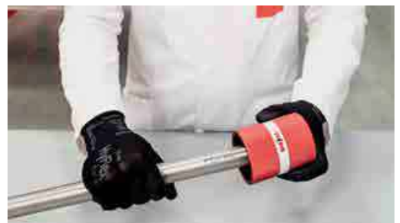
Рисунок 20 - Очищення труби від задирок
