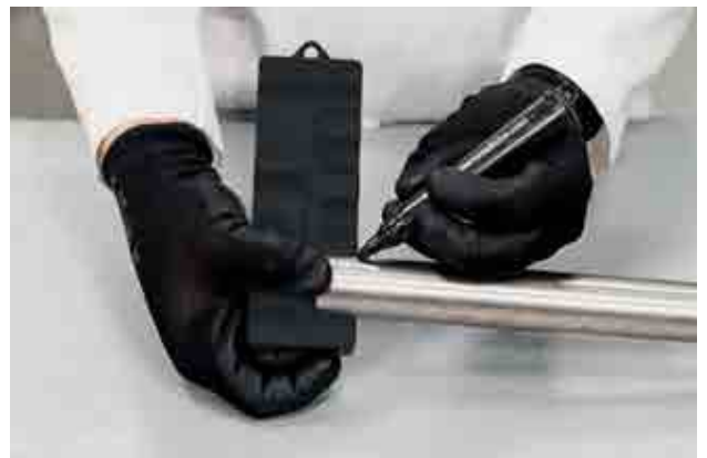
Рисунок 23 - Позначення глибини введення
