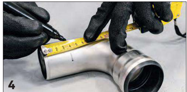
4 Marcatura quota d'innesto / Marking the insertion's depth
