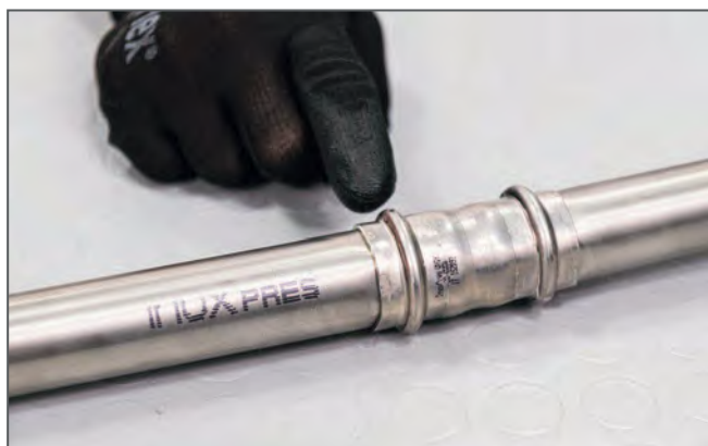
Controllo della pressatura / Checking the press connection
