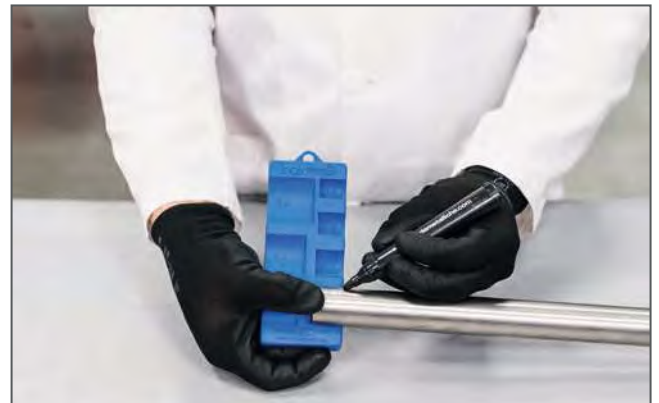
Marcatura della profondità d'innesto / Marking the insertion depth
