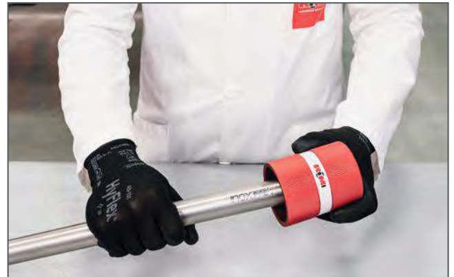
Sbavatura del tubo / Deburring the pipe
