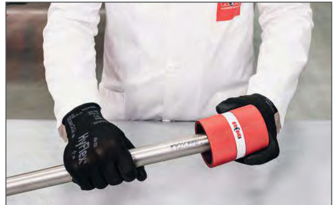
Sbavatura del tubo / Deburring the pipe
