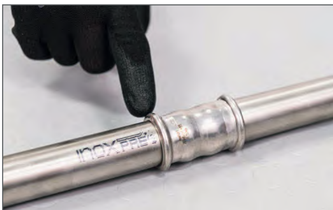
Controllo della pressatura / Checking the press connection
