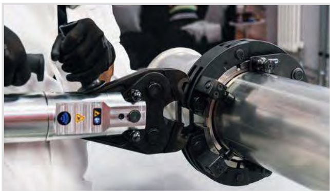
Assemblaggio pressatura n°1 / Press assembly phase 1
